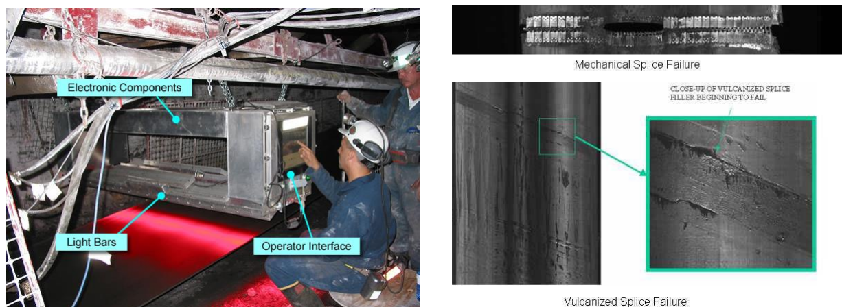
Rys. 2. System wizyjnej inspekcji taśm w trakcie działania. Przykłady rejestrowanych obrazów złączy mechanicznych i wulkanizowanych z oznakami uszkodzeń.
