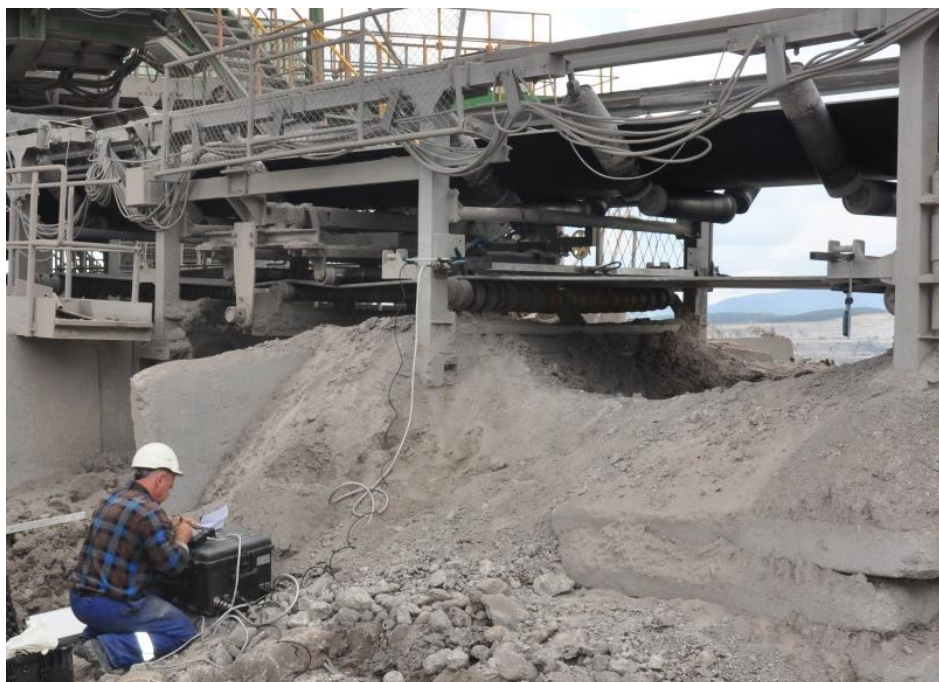
Rys.1. System podczas pomiarów w kopalni odkrywkowej Fig.1. System during measurements in opencast mine.
