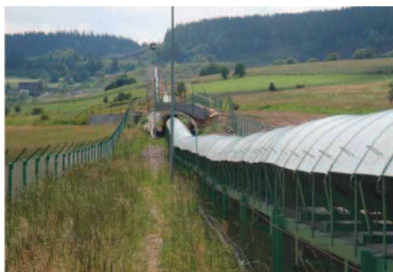
RYS. 2 Transport melafiru ze złoża „Świerki” przenośnikiem taśmowym (źródło: Siemens)
